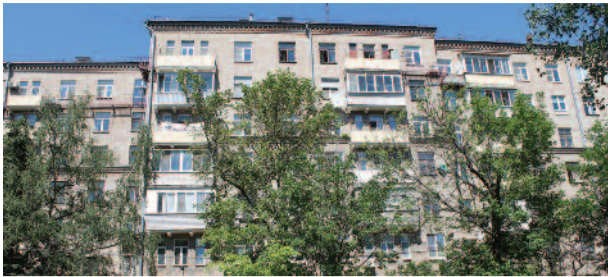
Капитальный ремонт: стало хуже, чем было стр. 4-5
