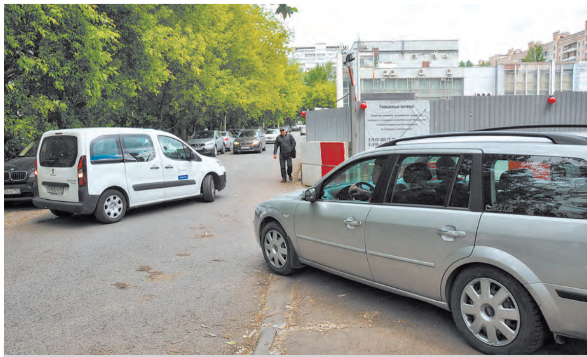
Строительный забор на месте тротуара
